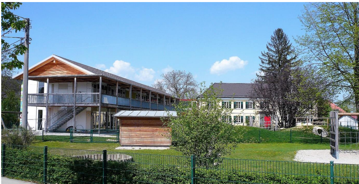
Das Haus für Kinder mit Krippe, Kindergarten und Hort. Hier soll es mehr biologische und heimische Lebensmittel geben. Foto: Archiv Höfer
