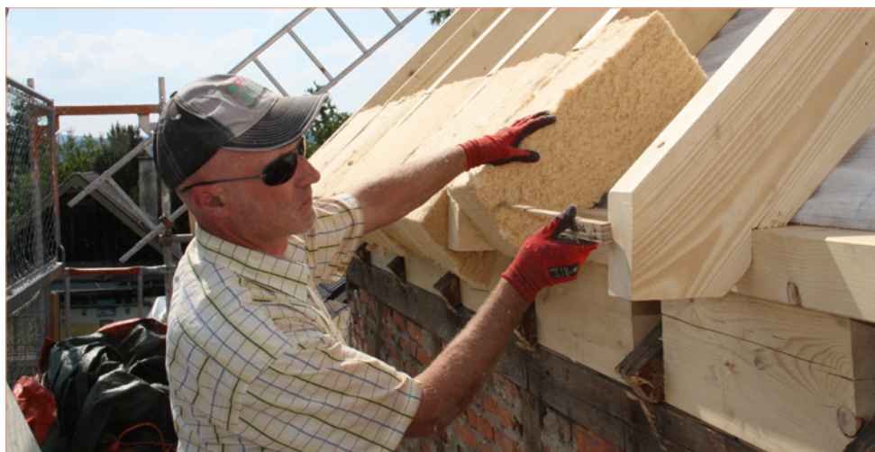
Dachdämmung von außen. Foto: eza!
