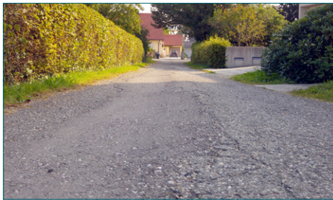
Gentnerstraße im derzeitigen Zustand
