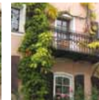
Rose (Spreizklimmer) mit Spalier, Glycinie mit Rankhilfe und Wilder Wein (Selbstklimmer) zur Fassadenbegrünung
