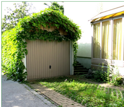
Eine begrünte Garage und eine Einfahrt mit begrüntem Rasengitter ist hier mit einem schattenspendenden Baum (außerhalb des Bildes) kombiniert. Die enorme hohe Verdunstungsfläche und senkt die Temperaturen erheblich und schafft ein angenehmes Mikroklima.
