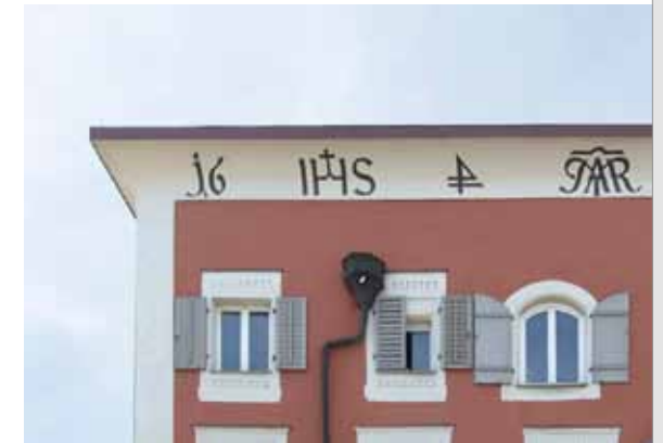
Beschriftung der die Giebelwand abschließenden Hohlkehle
